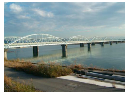
写真3 ■ 崩落以前の六十谷水管橋(写真:和歌山市)
